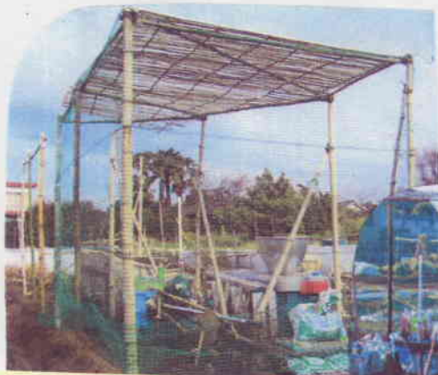
B1・B2 柵の補修 完了
